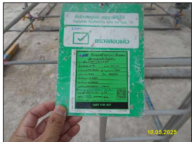
ข) การตรวจสอบสภาพความสมบูรณ์ของนั่งร้าน
