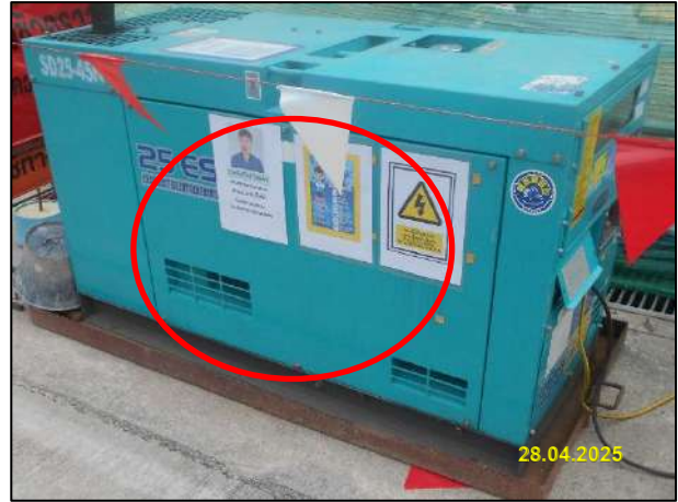
ก) ตู้เหล็กครอบเครื่องยนต์เพื่อลดระดับเสียง
