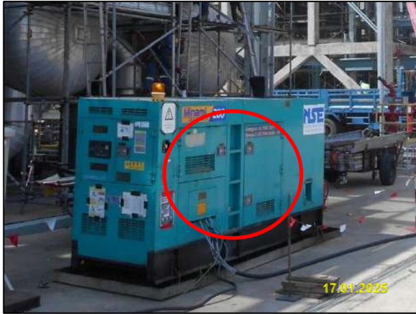
ก) ตู้เหล็กครอบเครื่องยนต์เพื่อลดระดับเสียง
