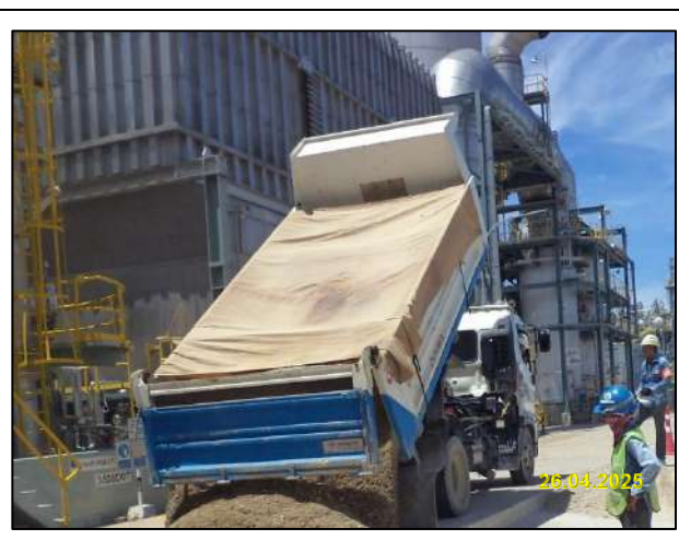
รูปที่ 2-4 รถบรรทุกขนส่งวัสดุก่อสร้างมีผ้าไปปิดคลุมอย่างมิดชิด
