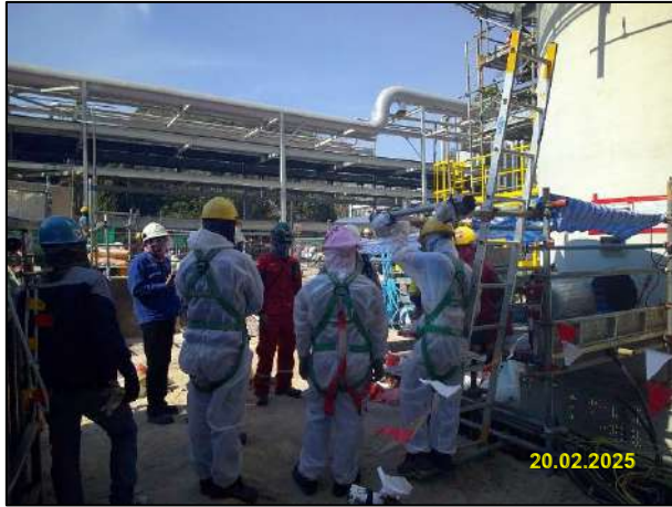
ผู้ช่วยเหลือ พร้อมด้วยอุปกรณ์ช่วยเหลือและอุปกรณ์ช่วยชีวิต บริเวณทางเข้า-ออกพื้นที่อับอากาศ
