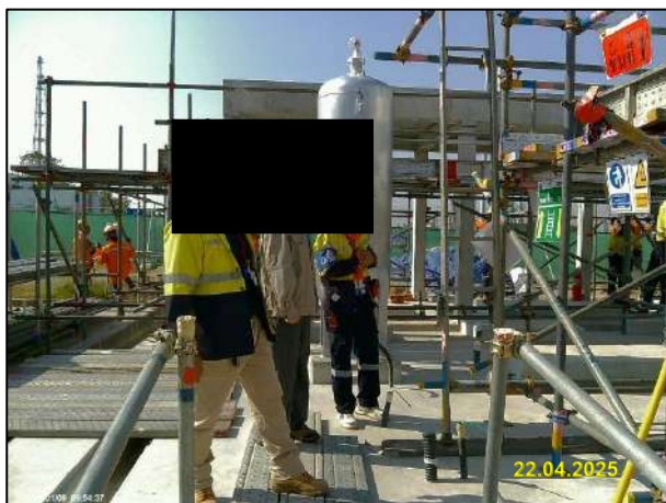
ข) การตรวจสอบสภาพความสมบูรณ์ของนั่งร้าน
