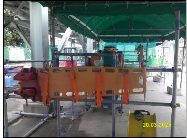
ผู้ช่วยเหลือ พร้อมด้วยอุปกรณ์ช่วยเหลือและอุปกรณ์ช่วยชีวิต บริเวณทางเข้า-ออกพื้นที่อับอากาศ
