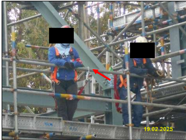
ค) อุปกรณ์ป้องกันการตกจากที่สูงขณะปฏิบัติงาน
