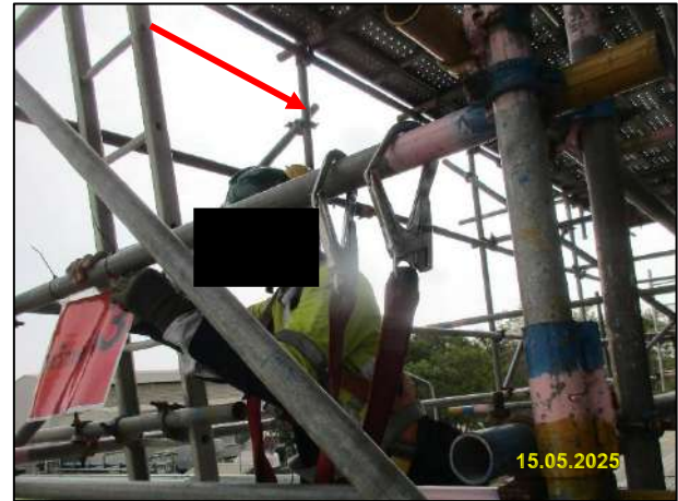
ค) อุปกรณ์ป้องกันการตกจากที่สูงขณะปฏิบัติงาน
